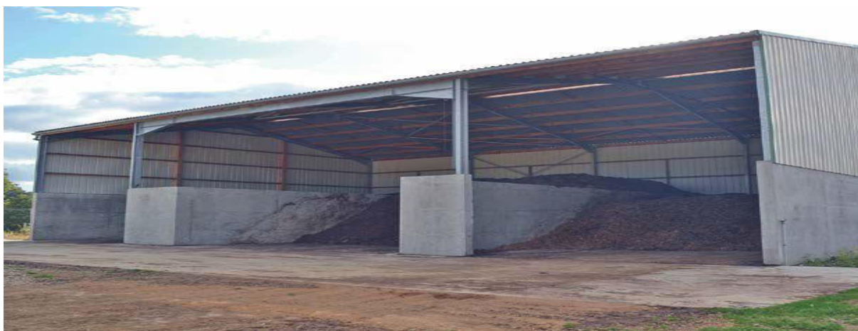
Figure IV-5 : Technologie de compostage en casiers
