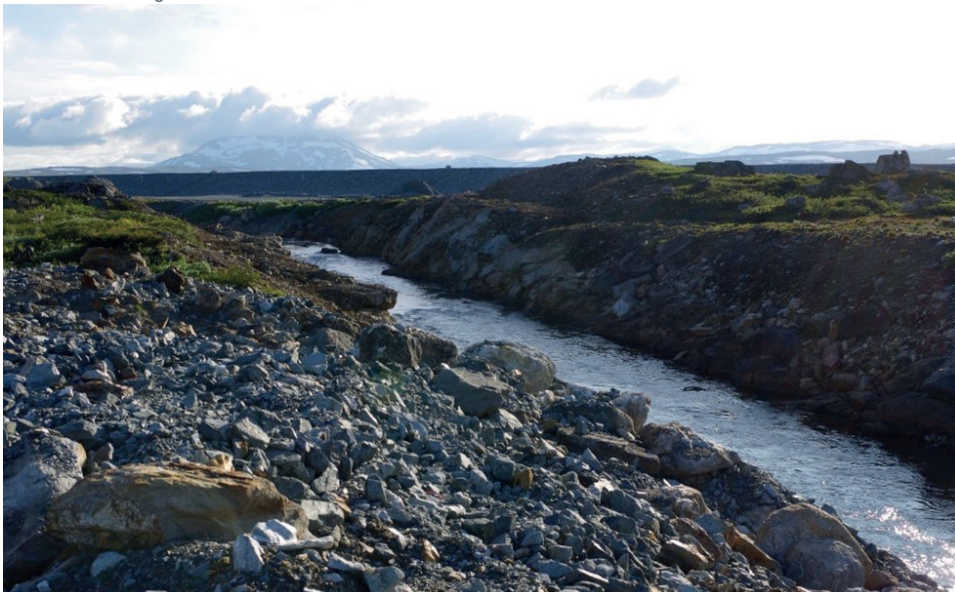
Figur 8. Den sprängde kanalen. Visar den kanal som sprängdes fram för att leda vattnet från gruvdammen, via klarvattenmagasinet och ut i Saxån.
