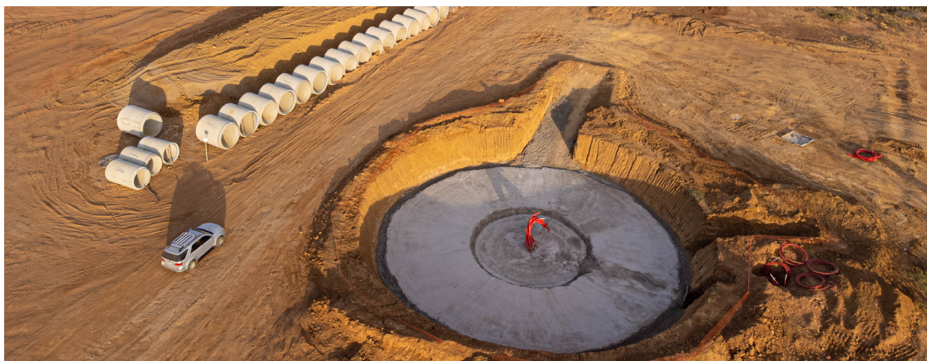
Base de aerogenerador del parque eólico Windpeshi. En 2023 la construcción de Windpeshi fue suspendida © EDUAR MONSALVE / SEI
