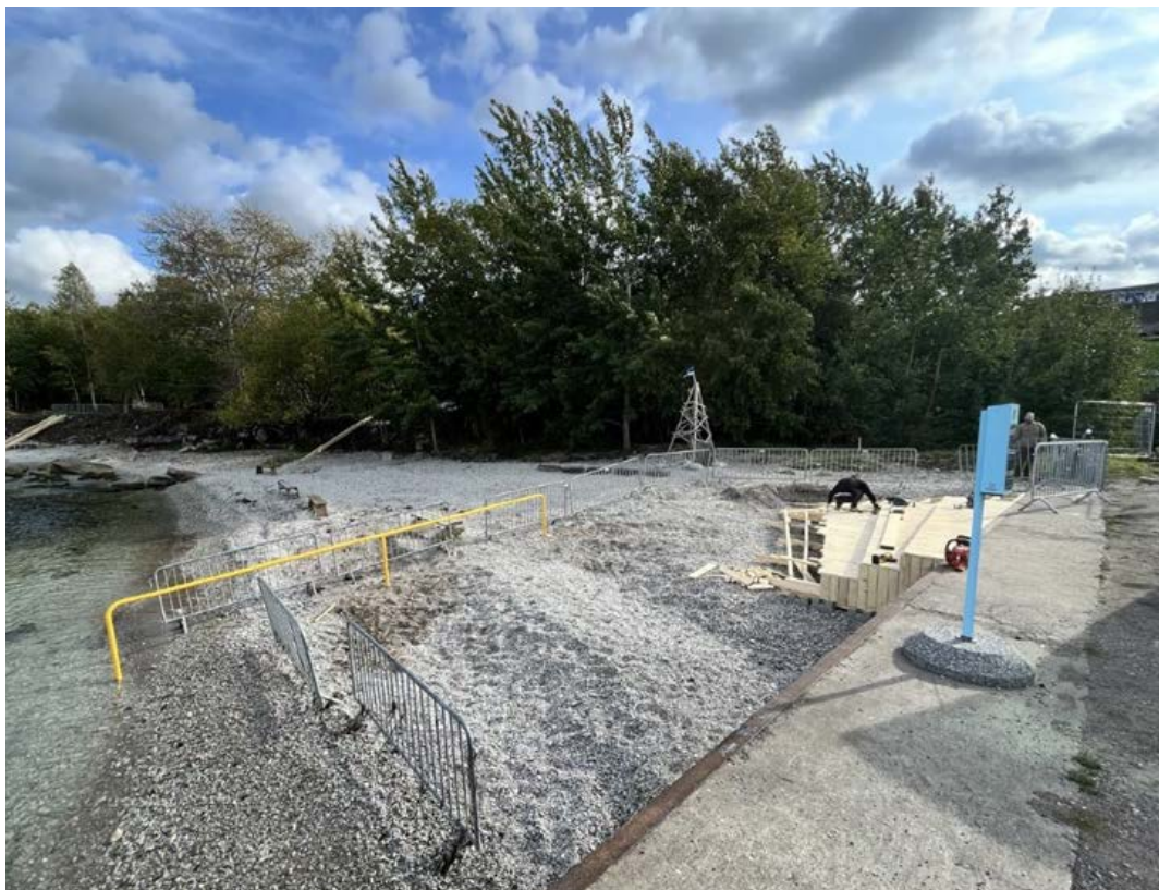
Joonis 46. Puidust trepi rekonstrueerimine (foto: SEI Tallinn).
